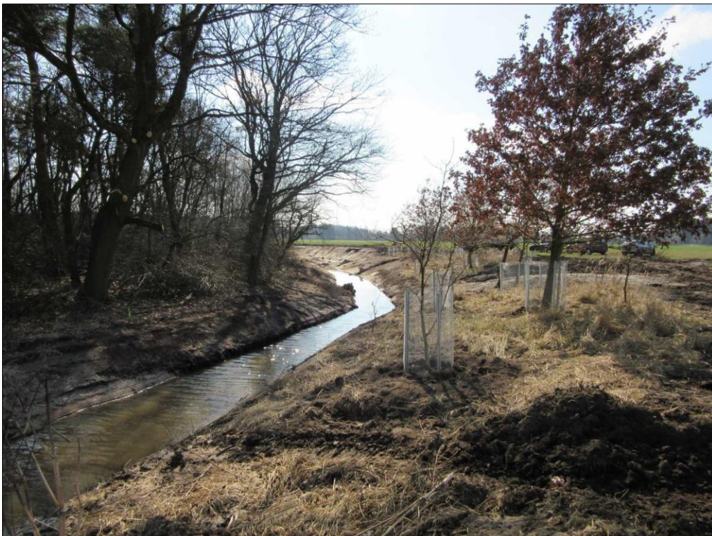
Abb. 2: Das Initialgerinne ist ausgehoben, noch fehlt der Anschluss an den Hauptstrom
