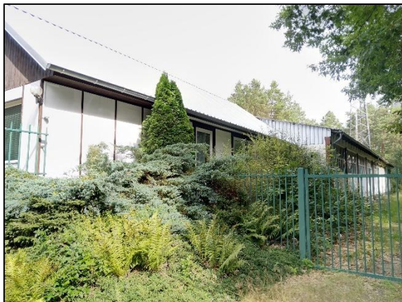
Abb. 1 Büro- und Verwaltungsgebäude Eichhorst; Stand 08/2021.
