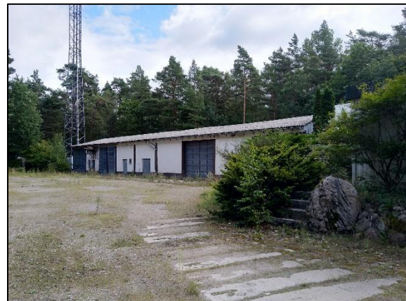
Abb. 2 Kühlhallen und befestigte Freiflächen Eichhorst; Stand 08/2021.
