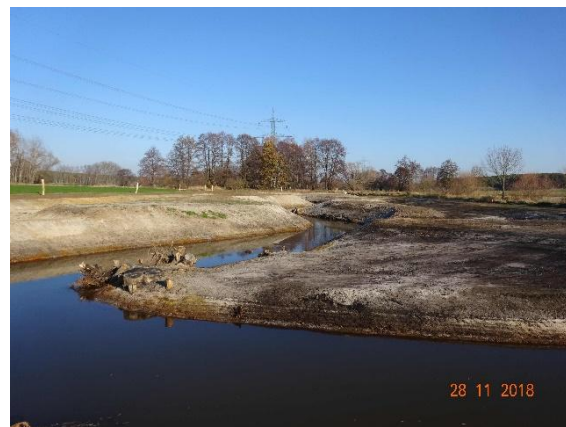
Elsterwiesenschleife kurz nach Fertigstellung 2018
