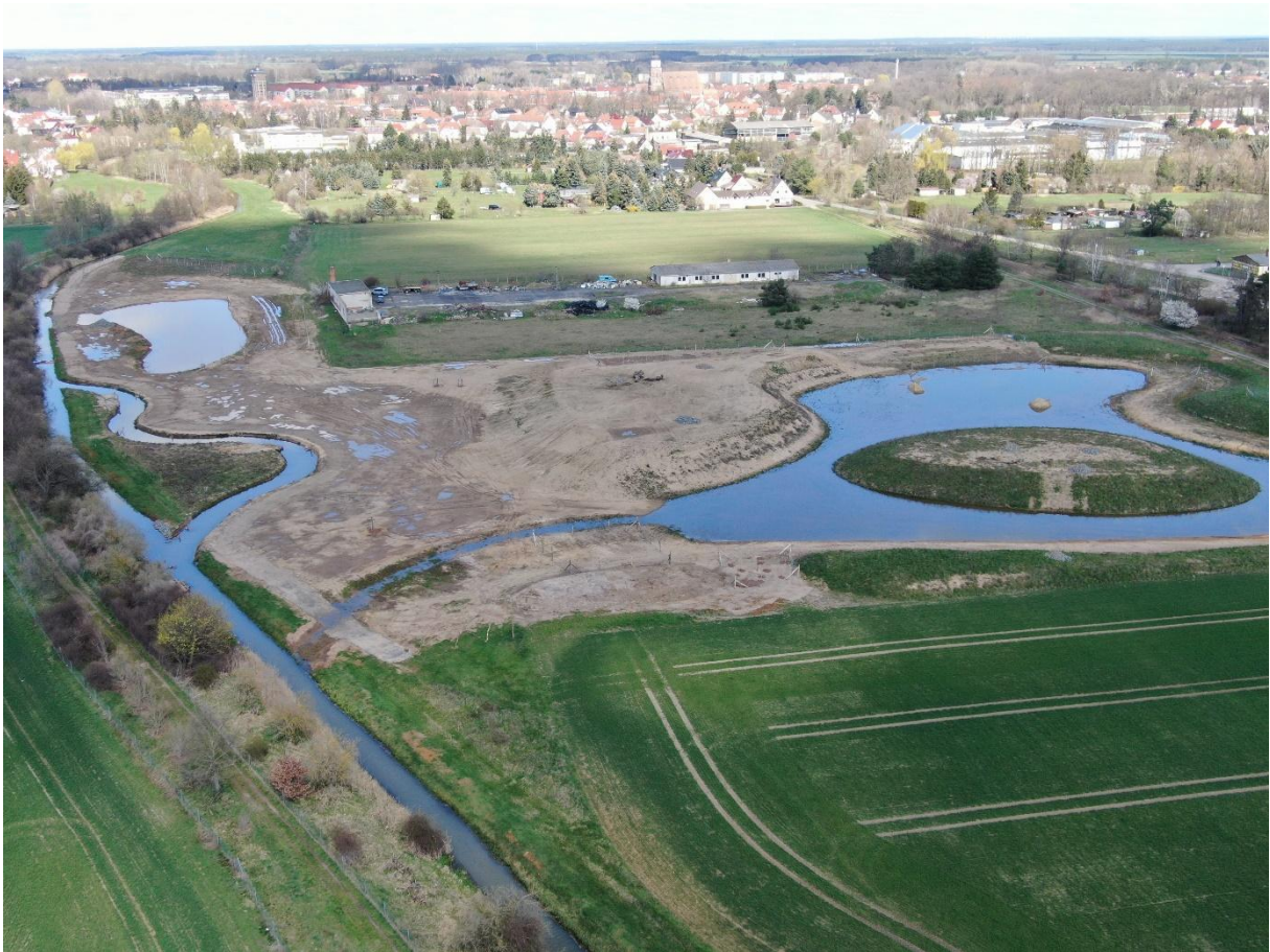
Kurz nach der Fertigstellung
