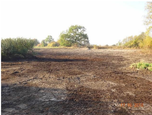
Nach Abschluss der Erdbauarbeiten
