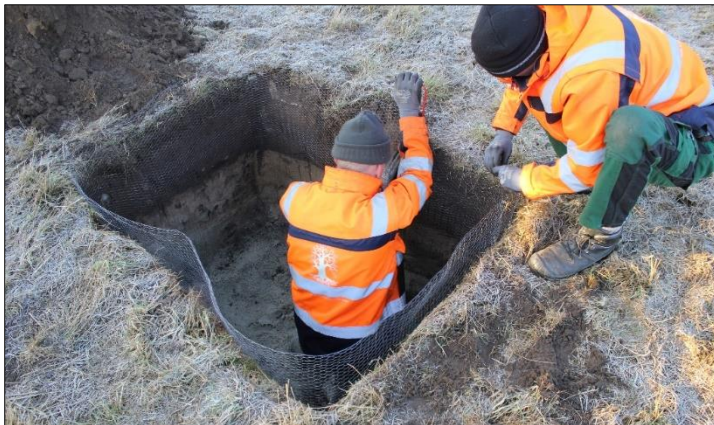
Verankerung des Schutzkorbes gegen Wühlmäuse (Foto A. Schöps)
