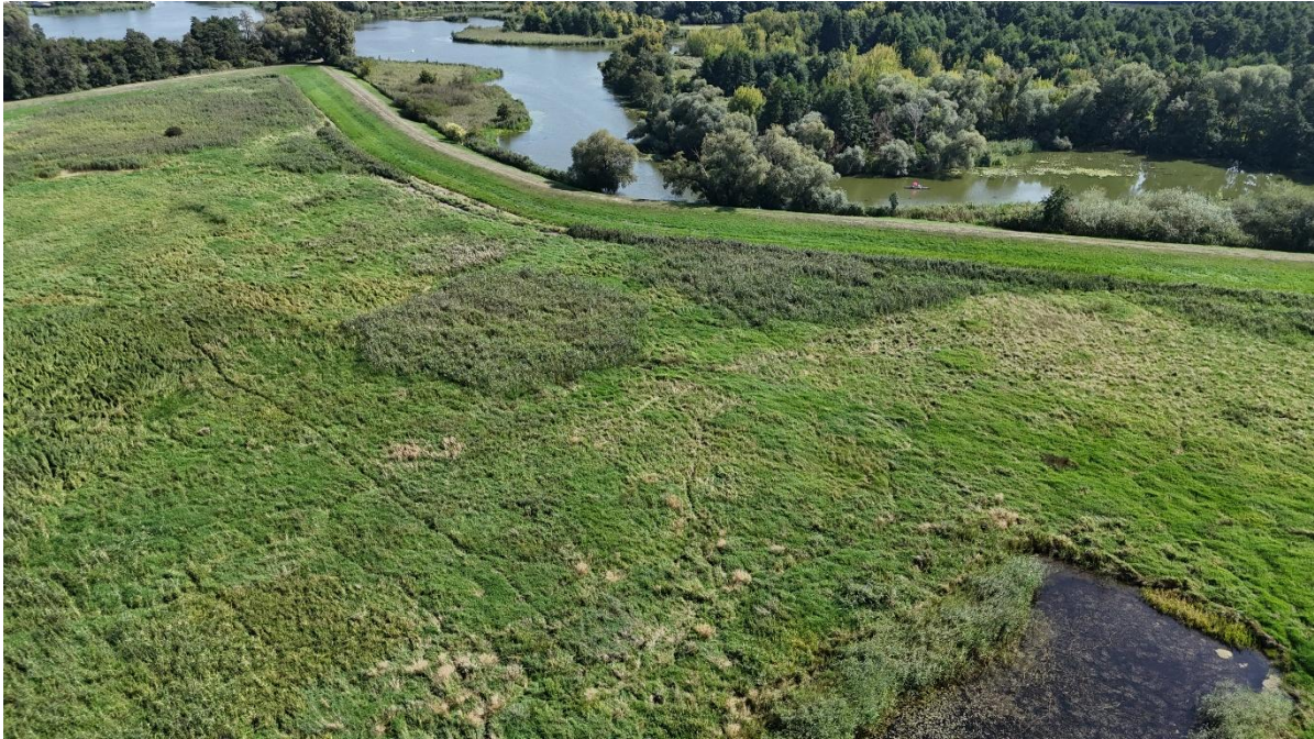
Abb. 10: Drohnenbefliegung der Senkenfläche im August 2024.
