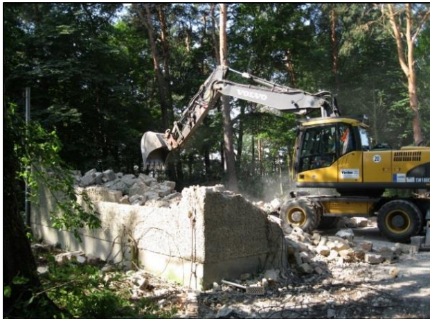
Abb. 1: Abriss und Entsiegelung im Maßnahmenbereich Weinberg Gräbendorf
