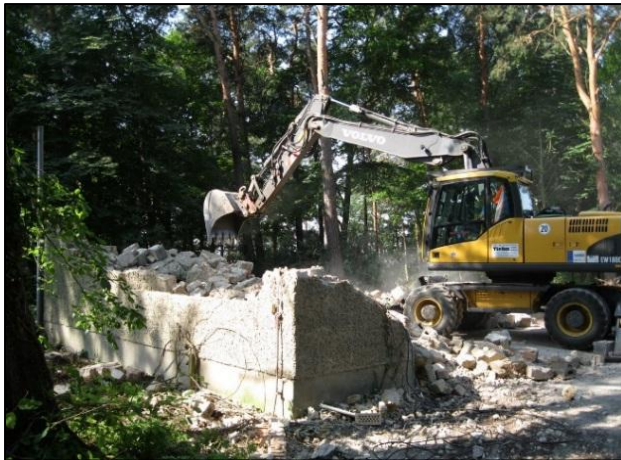
Abb. 1: Abriss und Entsiegelung im Maßnahmenbereich Weinberg Gräbendorf
