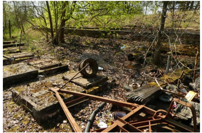
Abb. 4: Strukturen und Leitungsschacht neben der Ruine
