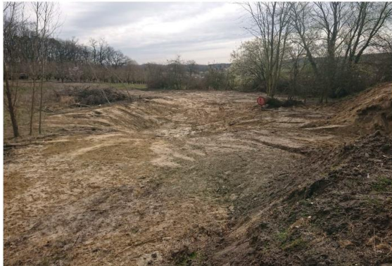
Abb. 7: Bereich Zuwegung Speicherbecken nach vollständigem Rückbau der Baulichkeiten
