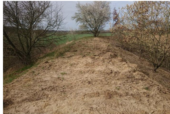
Abb. 9: Oberer Wallbereich nach Entfernung der Folienabdichtung
