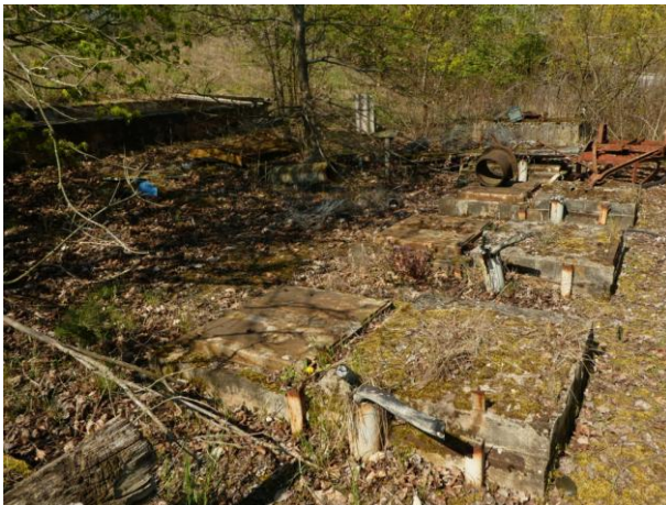
Abb. 3: Außenbereich mit flächenhaften Versiegelungen und technischen Strukturen
