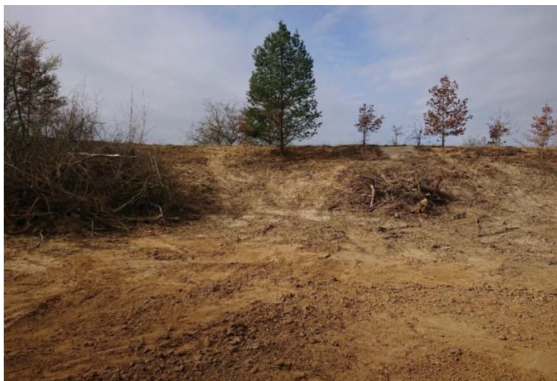
Abb. 8: Speicherbecken/Böschung nach Entfernung der Folienabdichtung
