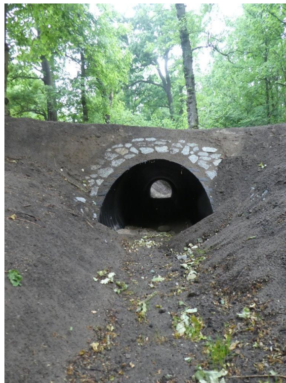
Abb. 4: Fertiggestellter Durchlass im Juni 2020 (Fotos: M. Szaramowicz)
