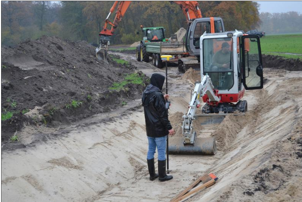
Abb. 5: Bau des neuen Fließgewässer-Abschnittes im Herbst 2021 (Foto: WLV „Untere Spree“)
