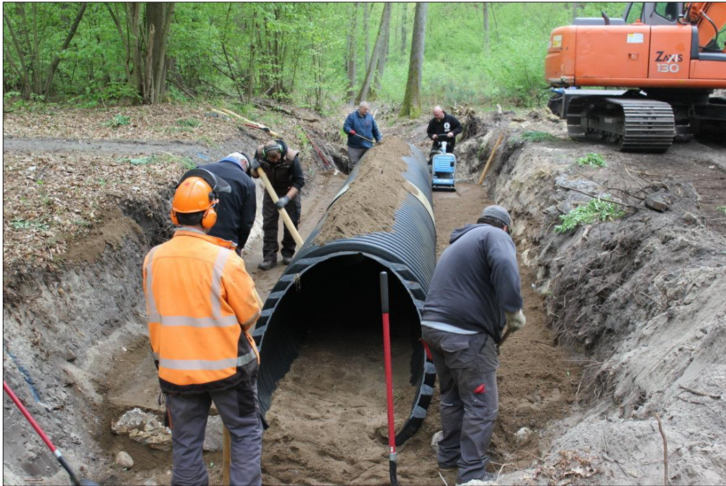
Abb. 3: Einbau eines lichten Rohres als Durchlass an einer der zu erneuernden Überfahrten im Mai 2020
