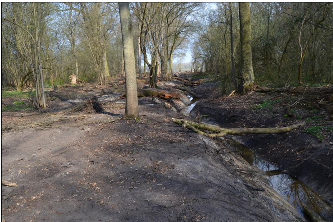
Abb. 6: Neu profiliertes Gerinne im Wald mit Totholz im Dezember 2021 (Foto: WLV „Untere Spree“)
