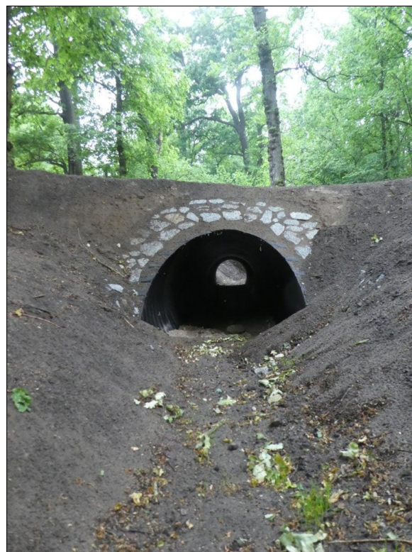
Abb. 4: Fertiggestellter Durchlass im Juni 2020 (Fotos auf dieser Seite: M. Szaramowicz)
