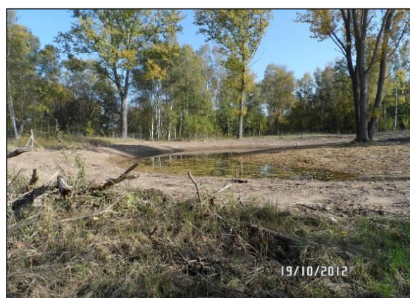
Amphibiengewässer kurz nach Fertigstellung
