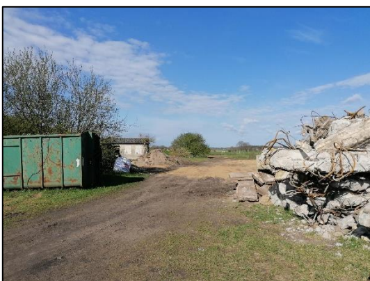
Abb. 5 Zwischenstand der Abrissarbeiten im Bereich der alten Zehlendorfer LPG (05/2021).
