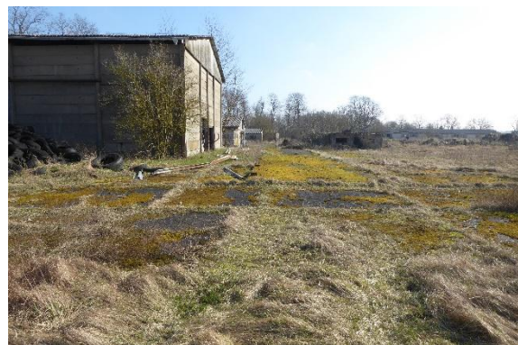
Abb. 2: Scheune westliche Seite
