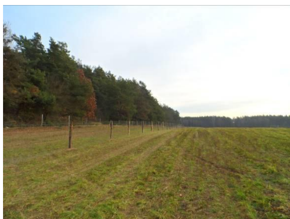
Abb.5: Zaunbau für Waldrandbepflanzung
