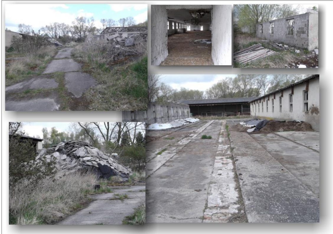
Abb. 1: Zustand vor der Entsiegelung
