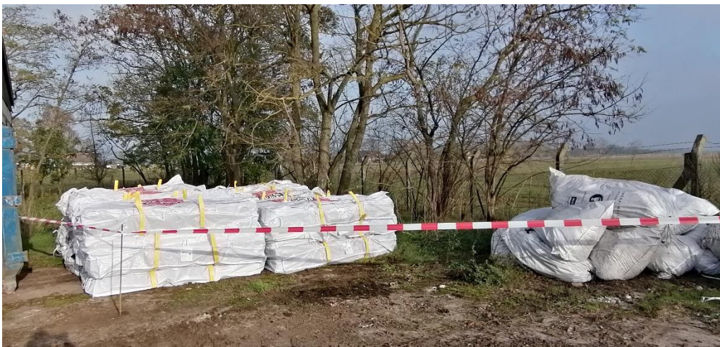
Zwischenlagerung der Asbestplatten
