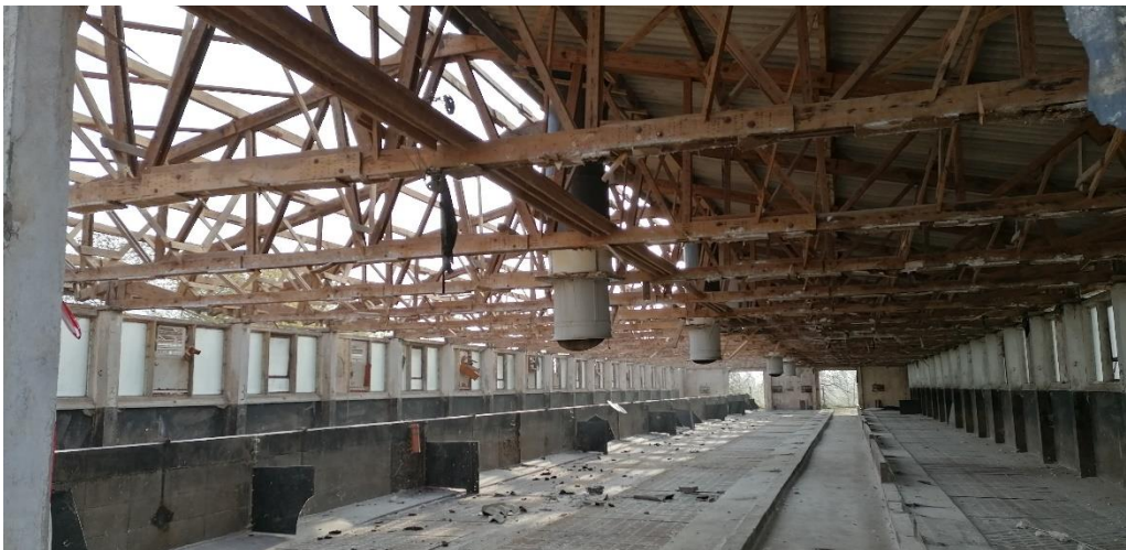
Rückbau einer der Ställe
