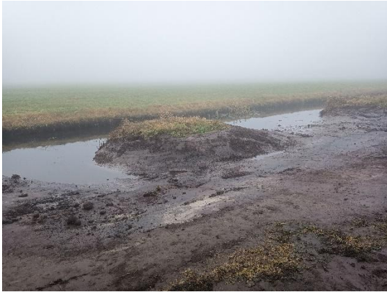
Uferabflachung am Graben
