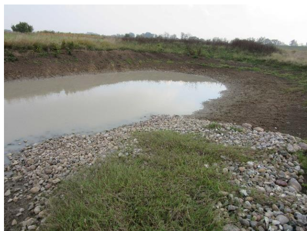
und im Qualmwasserbereich Lütkenwisch aus Januar 2016
