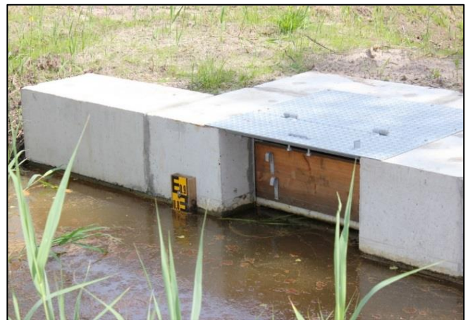
Abb.4: Vier rekonstruierte Staubauwerke sichern die Wasserhaltung der Teiche
