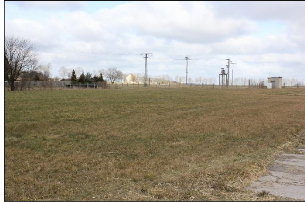
Abb. 2: Abrissfläche Milchviehanlage Welsickendorf (Foto: Anne Schöps)
