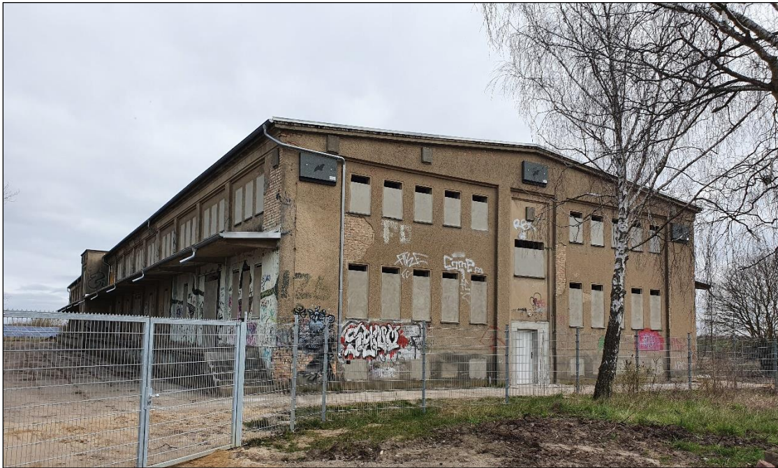
Außenansicht 01.04.2020 nach Abschluss der Bauarbeiten
