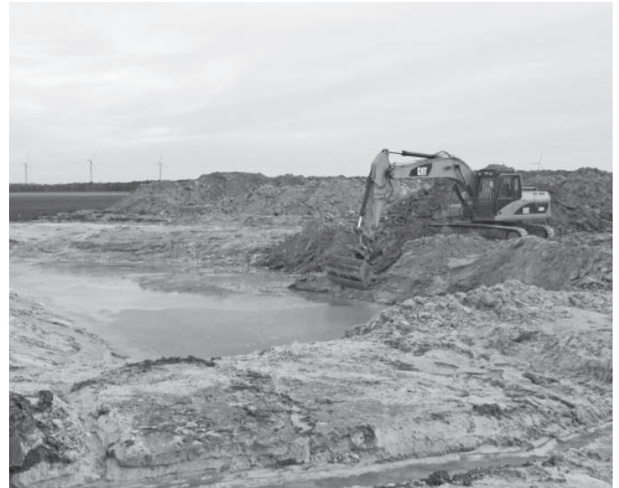
Aktuell wird im Flächenpool Stolzenhagen an der Anlage eines Kleingewässers gearbeitet
